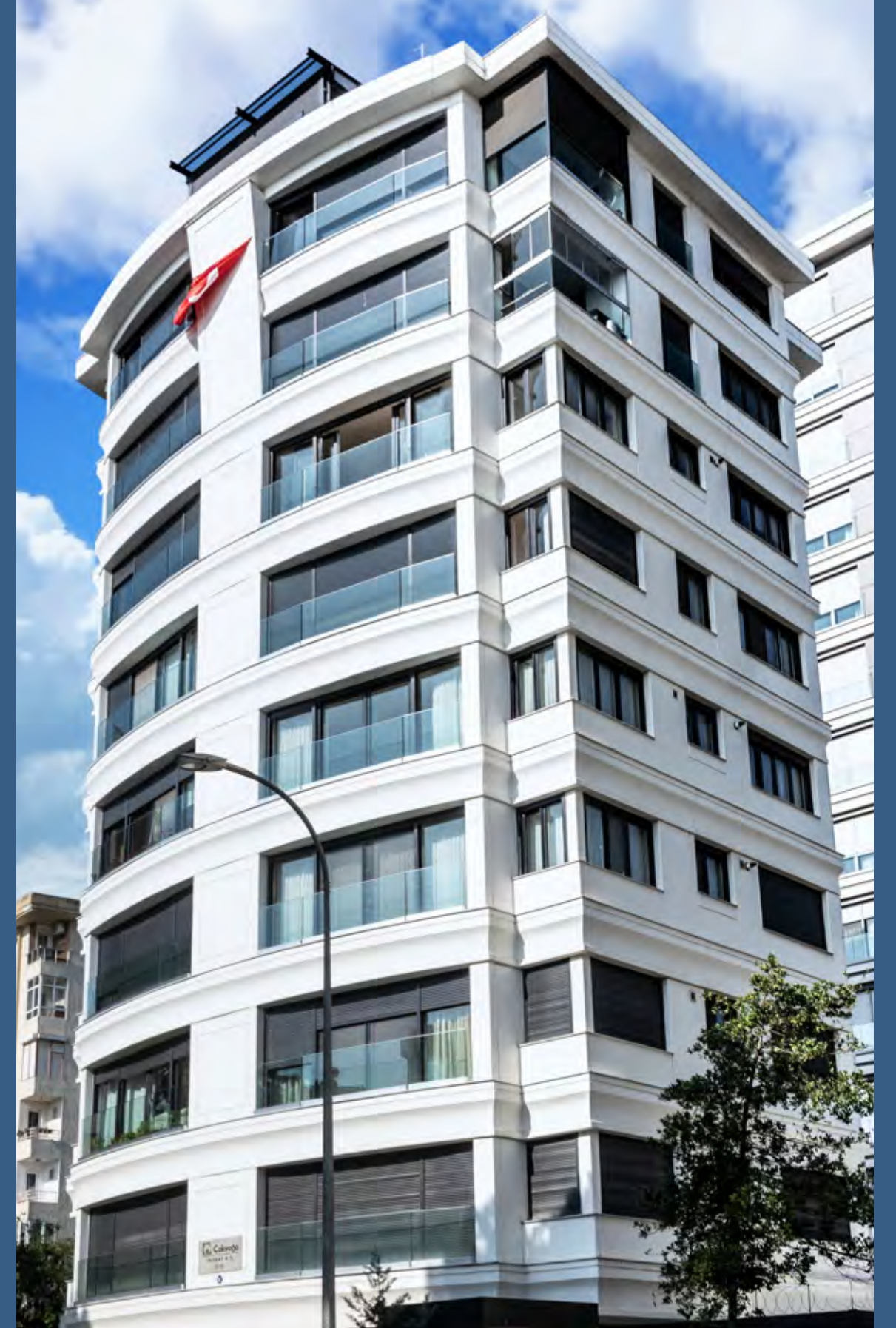
ÇAKIRAGA İNŞAAT Suadiye, Kadıköy istanbul
