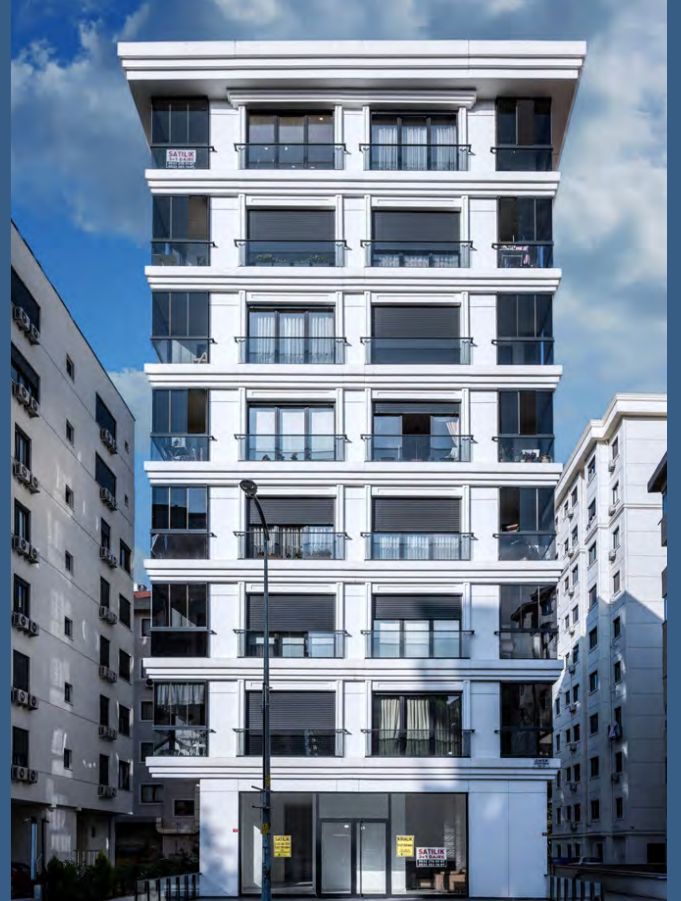
EKŞİOĞLU İNŞAAT 19 Mayıs Mah, Kadıköy İstanbul
